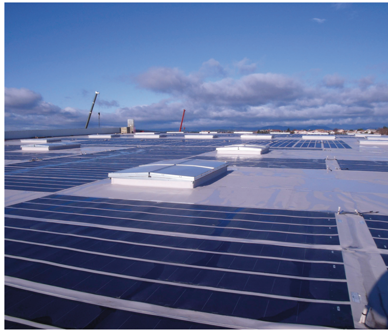
Urbasolar recouvre de membranes photovoltaïques 10 000 m 2 de toiture du nouvel entrepôt (38 000 m 2 ) de Lidl à Béziers, qui sera mis en service à la fin mai.
